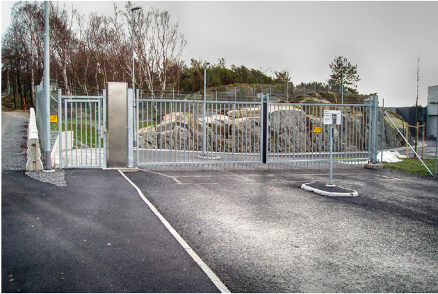
Gånggrind vid större slaggrind
